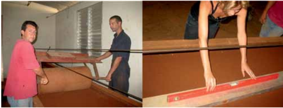
FIGURA 2. Compactación y nivelación del suelo en el canal de suelo.
