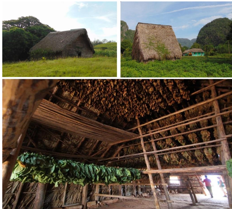
Figura 3. Tradicionales vegas de tabaco donde se almacena la hoja para el proceso de curado. Las vegas son construidas totalmente de madera con techos y cubierta de guano (especie perteneciente a la familia de las Arecáceas utilizada para construir techos de casas rurales, sombreros, cestos, canastos y escobas).
