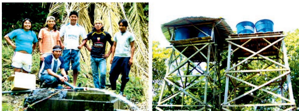
FIGURA 9. Fotos tomadas de la página WEB - Instalación de la bomba solar en Sharamentsa, Pastaza, Ecuador. Bomba Solar Lorentz PS 1200 con 8 paneles fotovoltaicos 100 W de potencia, altura de bombeo 30 metros, distancia de bombeo 800 metros, distribución 3000 metros. http://www.codesolar.com/Energia-Solar/Fotos/Bombas-Agua-Fotovoltaicos.html (Bombas Lorentz, 2015).
