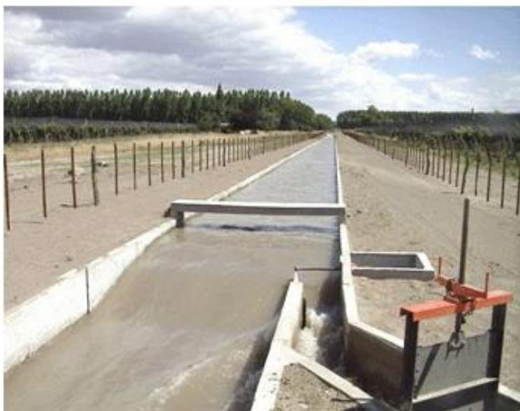
FIGURA 8. No se aprovechan las estructuras de aforo. Pocas Inspecciones usan las curvas de gasto de los aforadores para distribuir.
