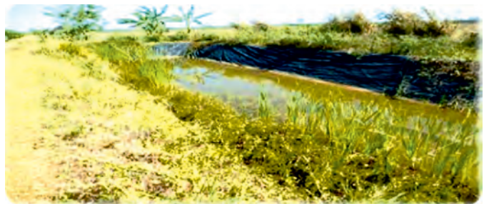
FIGURA 3. Canal de captación de agua de lluvia.
