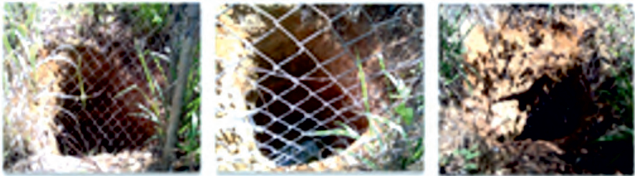
FIGURA 2. Imágenes del pozo y sus limitaciones (bajo nivel de agua y derrumbes en las paredes).
