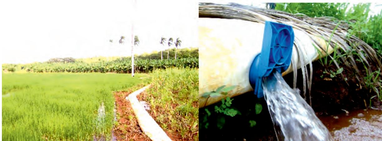
FIGURA 3. Tubería flexible y compuertas regulables.
